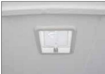
**Dachluke** mit Fliegengitter in Sattelkammer
